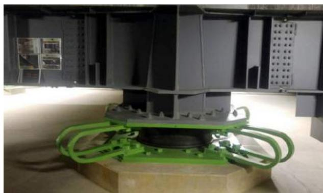
Gambar 6 : Ruang bawah tanah yang dilengkapi dengan *Kajima Anti Seismic Technology*, *seismograf* dan gudang penyimpanan makanan
