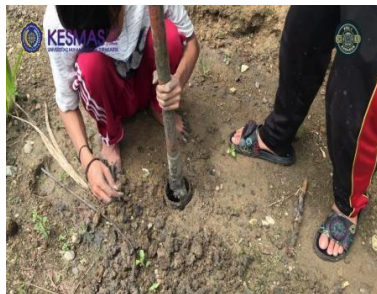
Gambar 1. Pemasangan Percontohan Lubang Resapan Biopori
