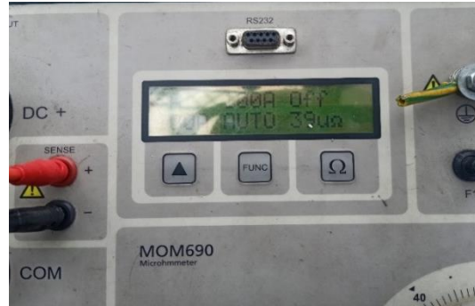
Gambar 6. Hasil pengukuran tahanan kontak pada PMT fasa S
