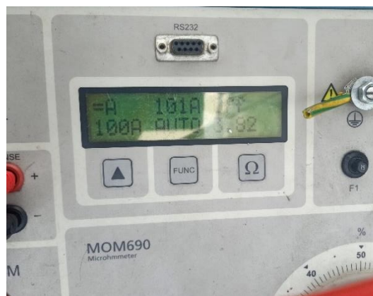
Gambar 5. Pengukuran tegangan pada PMT fasa R.
