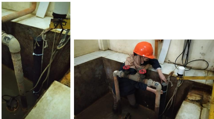
Gambar 6. Realisasi pemasangan sistem
