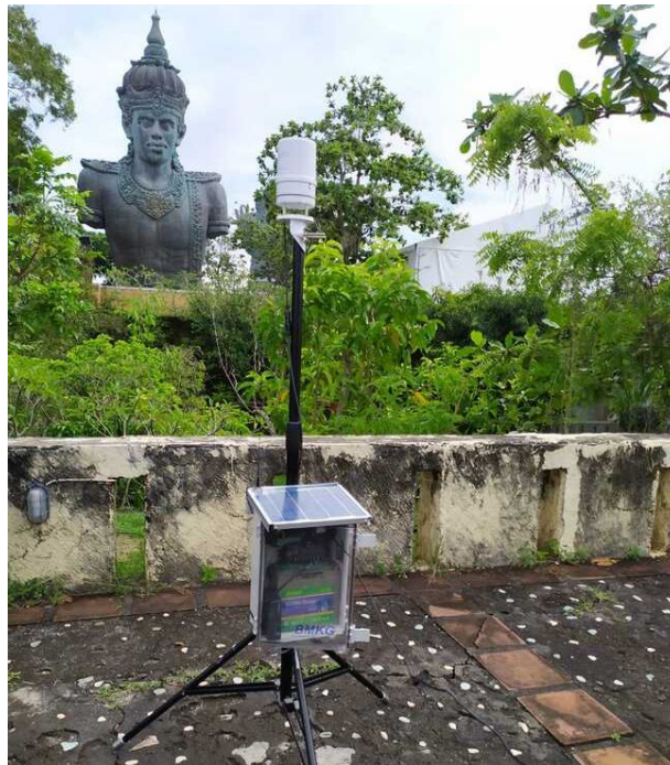
Gambar 3. Sistem yang telah terpasang
